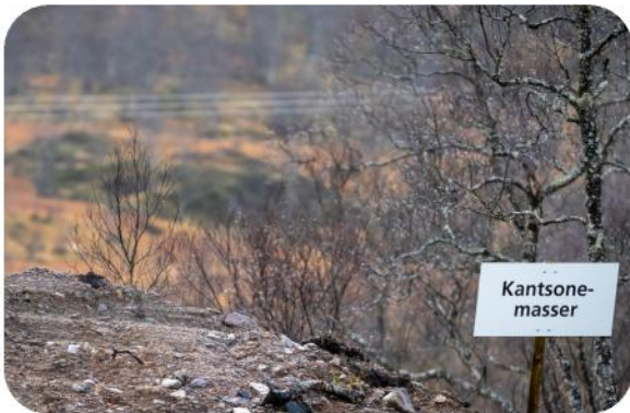
Skilting av kantsonemasser på E10 Hålogalandsvegen
