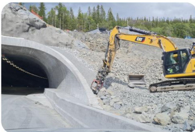
Tunnelportal ved E16 Kvamskleiva
