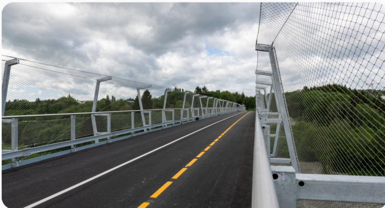
Ferdigstilling av Saupstadbrua, Contur
