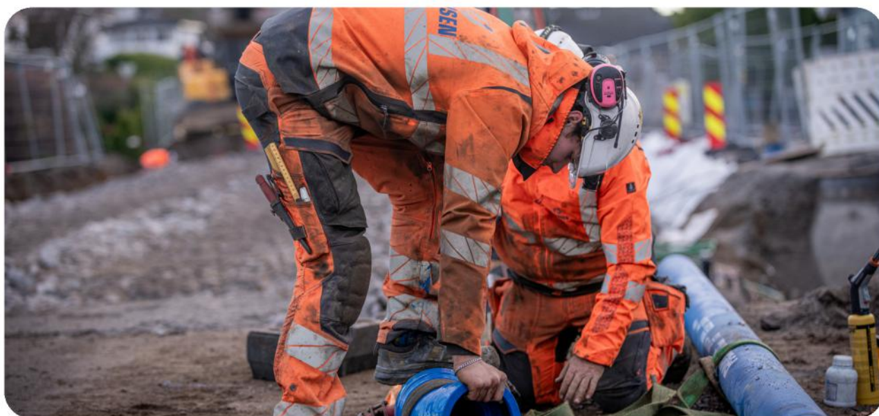
ADK-rørleggere hos Isachsen i prosjekt Dølebakken VA, Sandefjord
