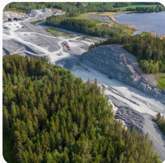
E6 Kvithamar - Åsen under bygging
